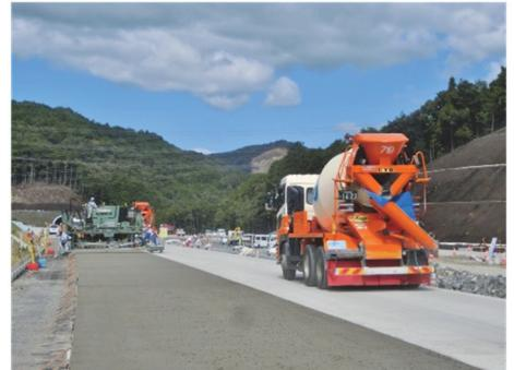
写真3 本線コンクリート舗装
